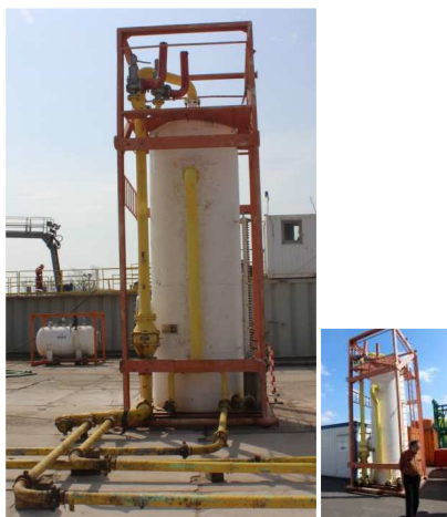
Rys. 12. Odstojnik komina zrzutowego w analizowanej instalacji.
