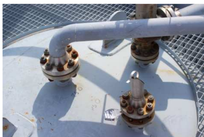
Rys. 18. Separator pionowy - elementy zasilania i odprowadzenia gazu.
