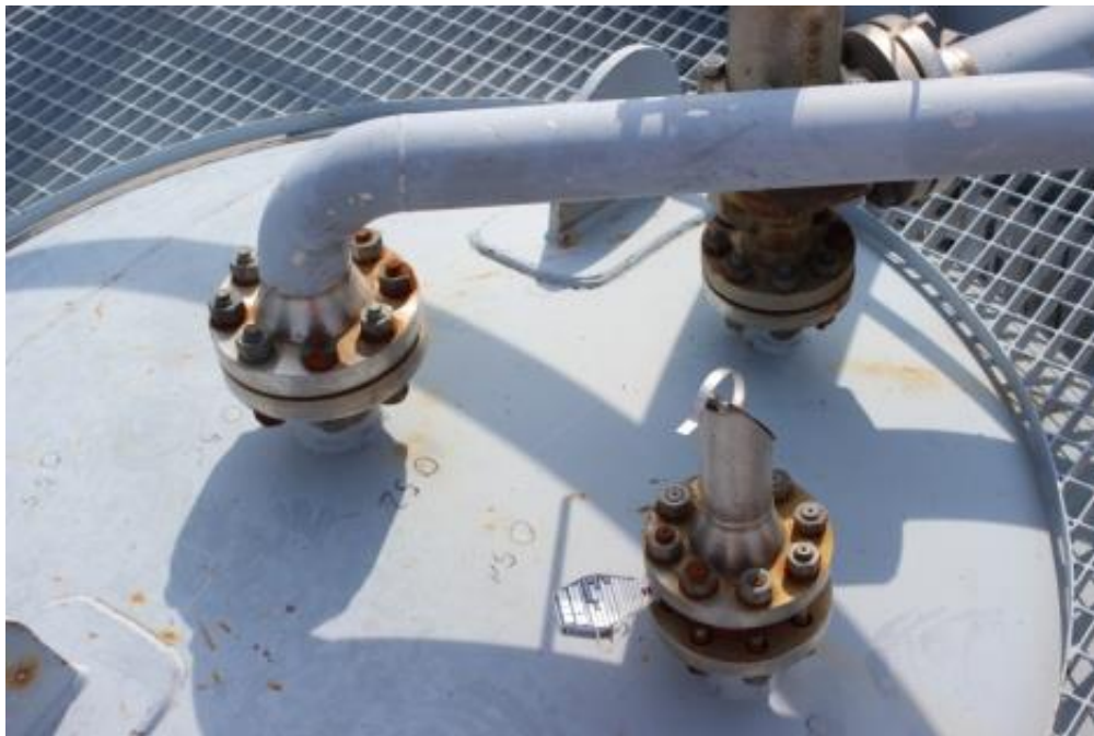
Rys. 22. Separator pionowy - elementy zasilania i odprowadzenia gazu.
