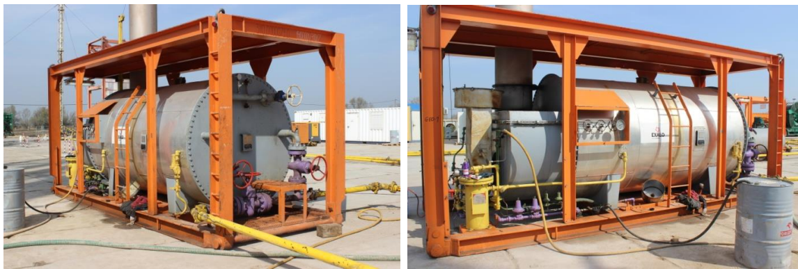
Rys.11 a; b. Podgrzewacz w istniejącej instalacji
