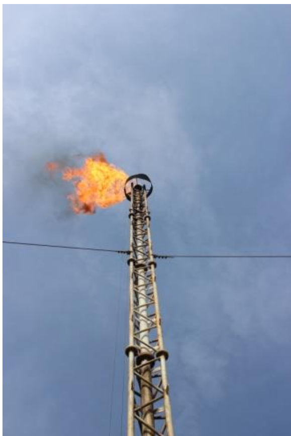
Rys. 18. Odstojnik komina zrzutowego w analizowanej instalacji.
